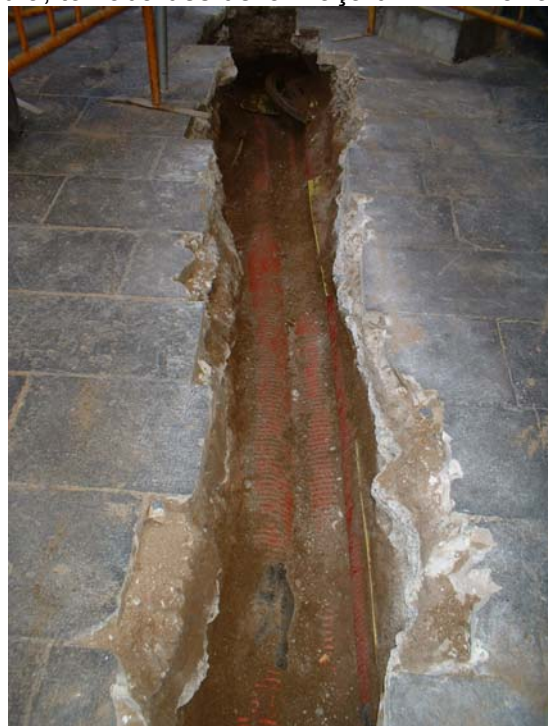
Fotografia 2: Tram de la Rasa 100 amb el servei d'alta tensió anterior passant per mateix traçat.
